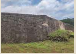
主郭南西部 (切込接ぎ・乱積み)
